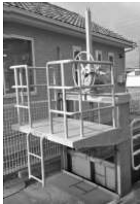
樋門の電動化も内水対策の一つとして進んでいます
