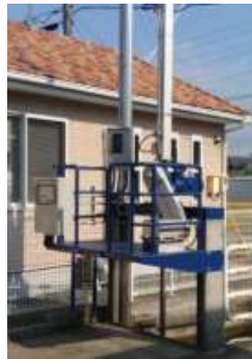
樋門の電動化も内水対策の一つとして進んでいます
